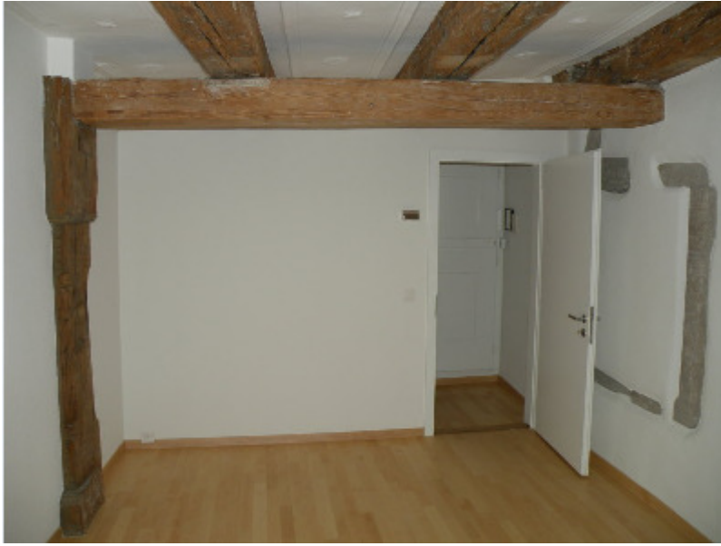
Münstergasse 10, 8001 Zürich (mittelalterliche Reste)
