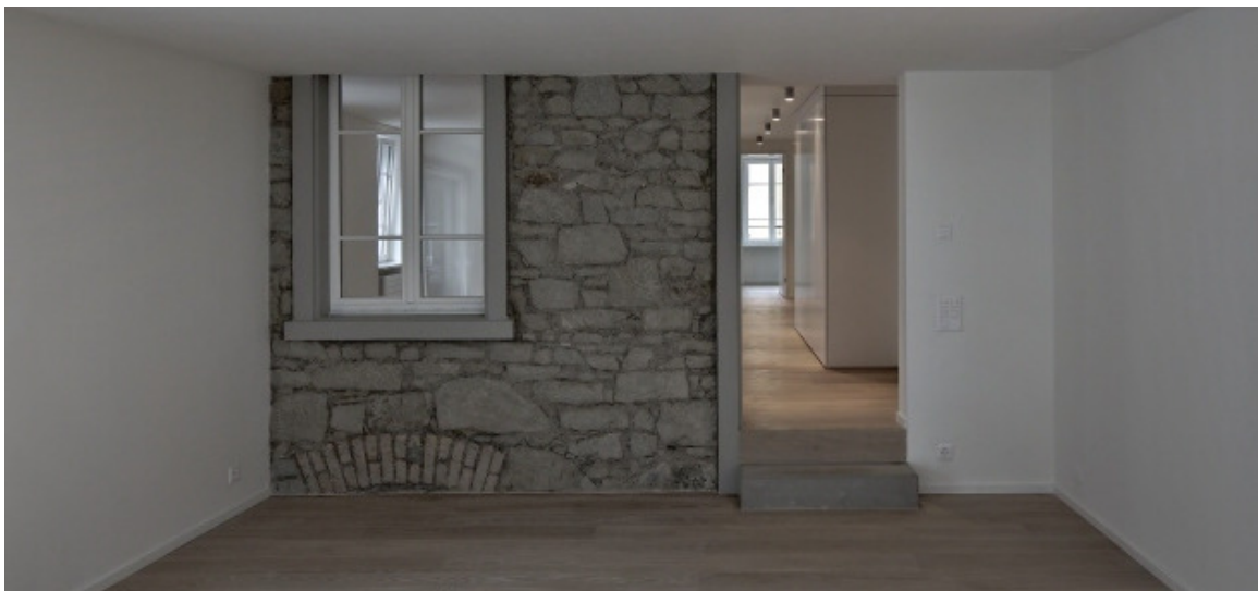
Hönggerstr. 20, 8037 Zürich (Hausanbau an Außenwand des Altbaus)
