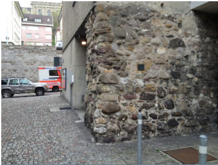
Seilergraben, 8001 Zürich (Rest der Stadtbefestigung)
